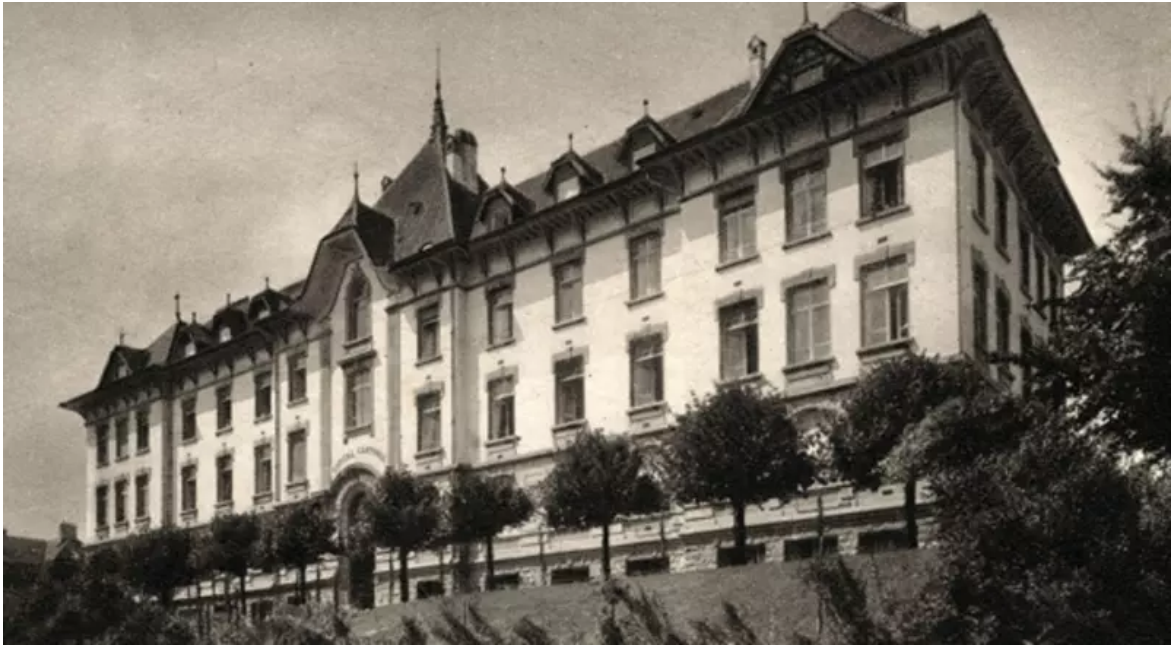
l'Hôpital cantonal de Fribourg, à Gambach
