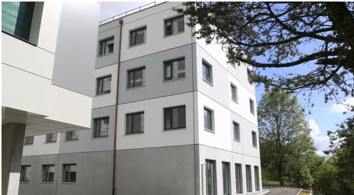
Le nouveau bâtiment du master en médecine
